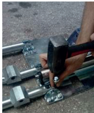
Slika 10 - Namestitev sidra
