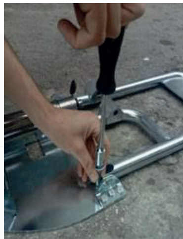
Slika 11 - Pritrditev zapornice
